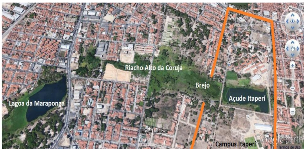
Figura 1: Vista do açude da UECE e seu entorno
